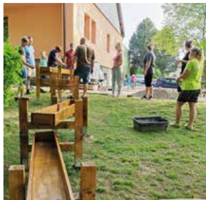
Rodiče se podílí na výstavbě vodního prvku v zahradě MŠ Zbraslavice
