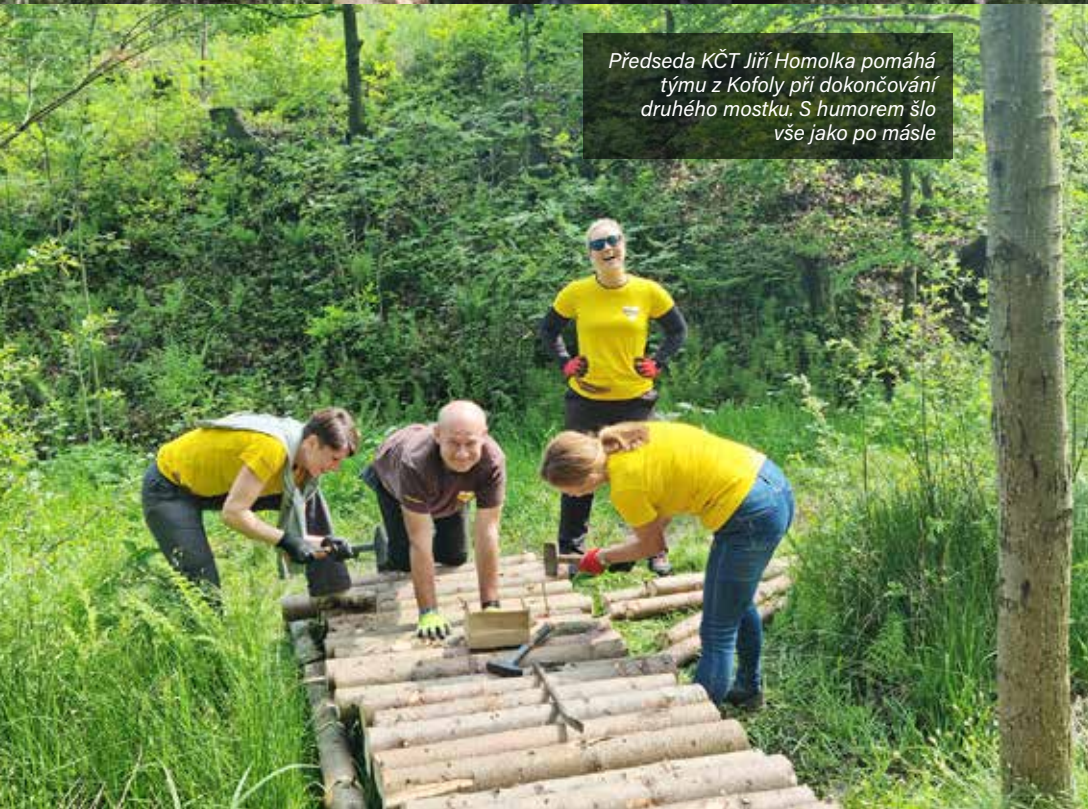
Poražený strom jako základna pro nový mostek. Do těžké práce se zapojili naprosto všichni, včetně Radima Jančury a Jannise Samarase
