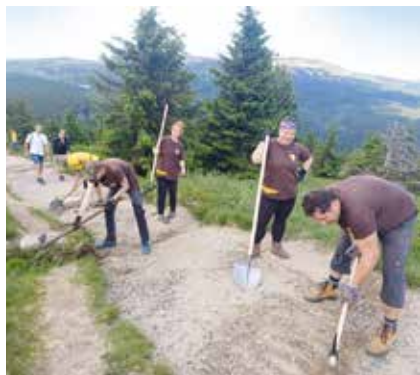
Práce na odvodňovacích strouhách
