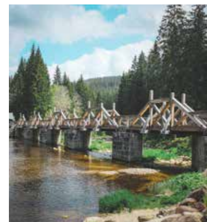
Hradlový most Rechle
